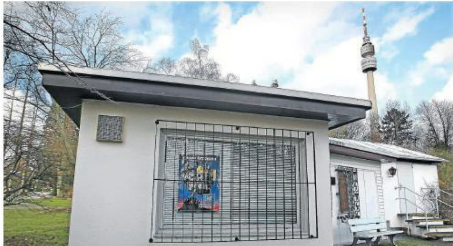
In diesem eher unscheinbaren Gebäude finden die Besucher die Sternwarte.
